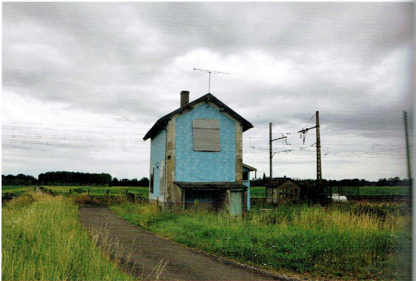
↑ La maison de garde-barrière d'Uchizy, en bordure de la D906 (anciennement N6) a été démolie dans la nuit du lundi 26 octobre 2020. Hors service depuis environ 25 ans, elle est tapissée de papier bleu sérigraphié par l'artiste Juliette Miséré en 2017.
